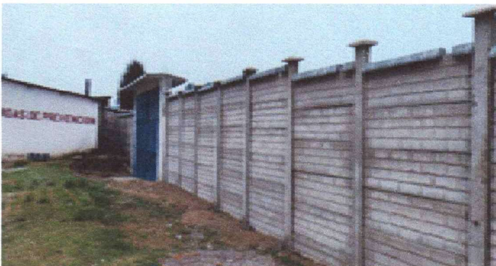
Foto 3: Vista del muro perimetral Interior
