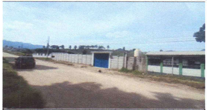
Foto 2. Vista del primer portón del muro perimetral
