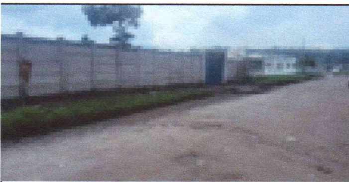
Foto 5: Vista del muro perimetral Exterior Final
