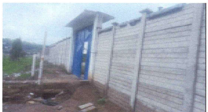
Foto 4: Vista del muro perimetral Exterior
