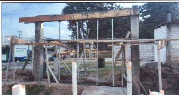
Foto1: Vista del espacio de construcción
