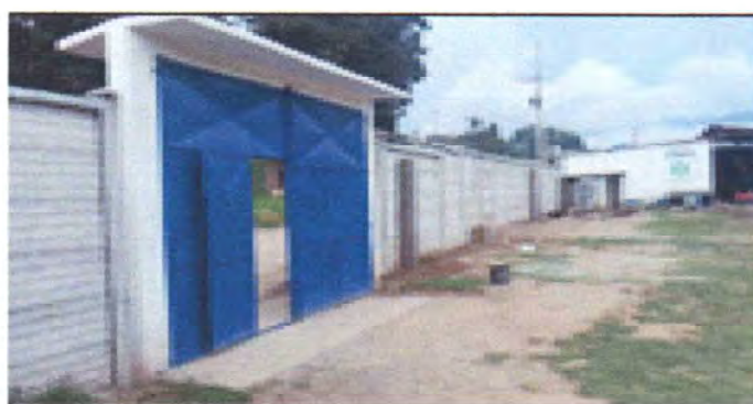
Foto 6: Final del muro perimetral
