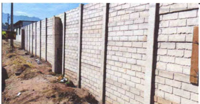
Foto 5: Vista del muro perimetral
