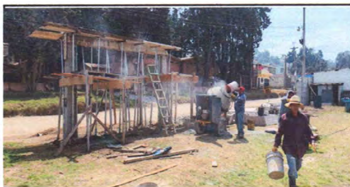
Foto 3: Vista de la construcción del portón del muro perimetral
