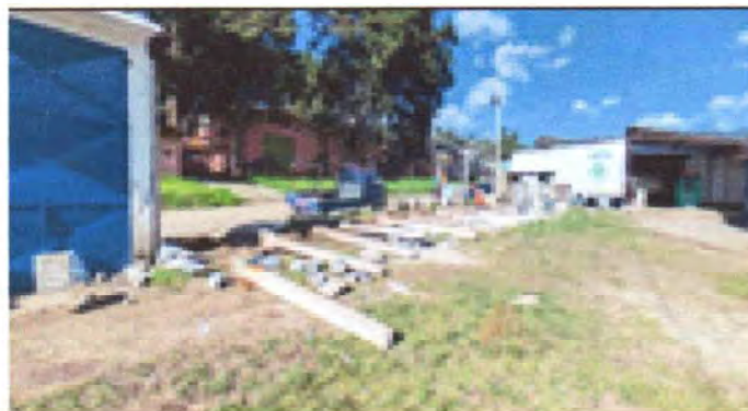
Foto 4: Vista de la colocación de poste del muro perimetral
