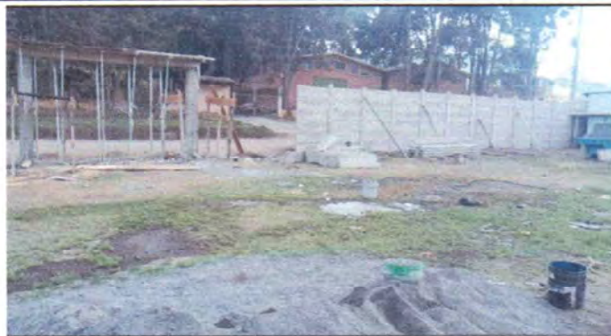
Foto 2: Vista del espacio del terreno a construir el muro perimetral..
