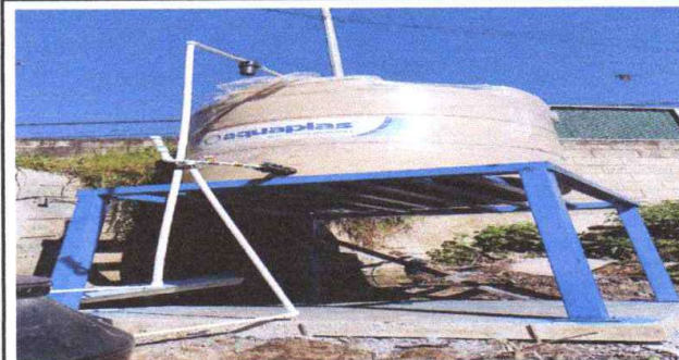
Foto 6: Saneamiento y deposito de agua
