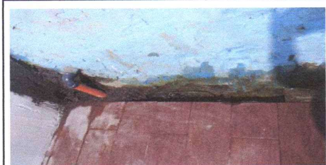
Foto 3: Sustitución y mantenimiento de cuneta de agua pluvial
