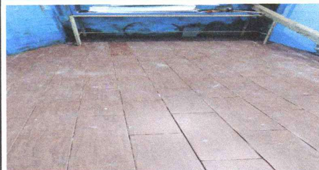
Foto 4: Sustitución de piso ceramico en dirección
