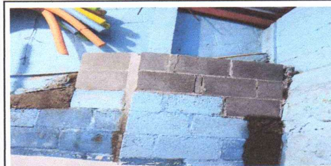
Foto 5: Mantenimiento de muro perimetral
