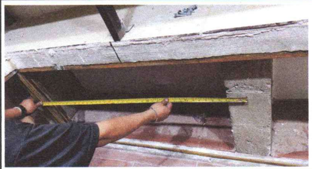
Foto 2: Suministro e instalación de mesas de trabajo y estantería para cocina.
