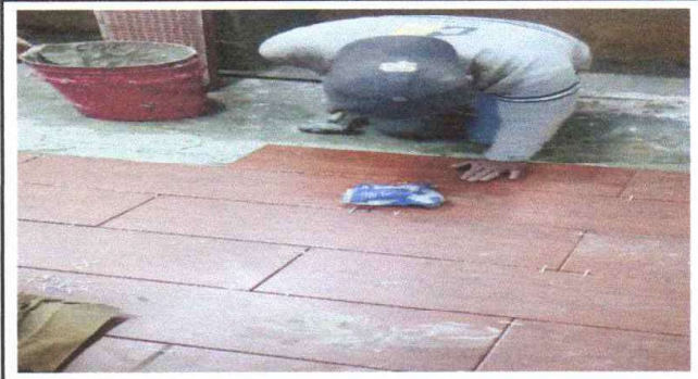
Foto 4: Sustitución de piso cerámico en dirección
