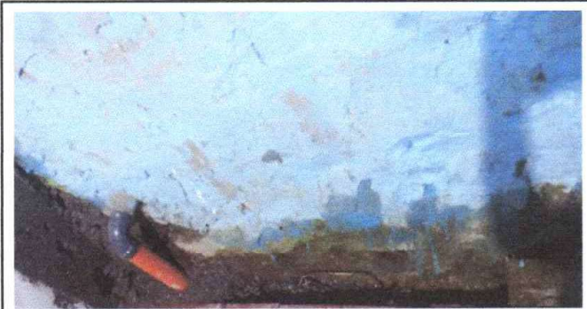
Foto 3: Sustitución y mantenimiento de cuneta de agua pluvial
