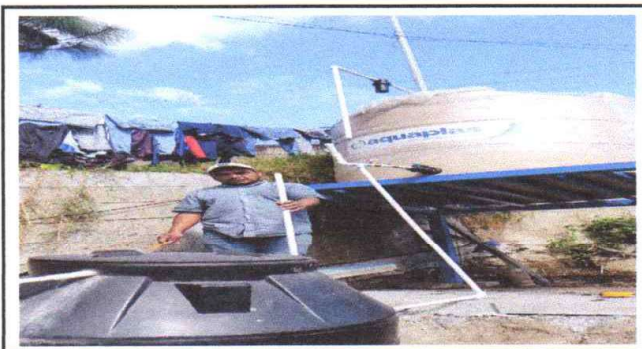
Foto 6: Saneamiento y deposito de agua
