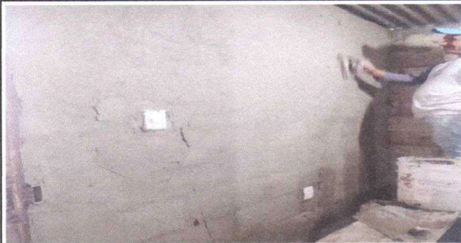
Foto 1: Mantenimiento de muros con repello e impermeabilización
