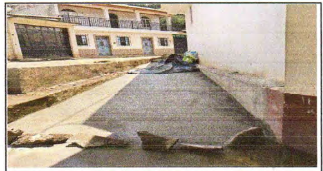
Foto 4: Arreglo de banqueta
