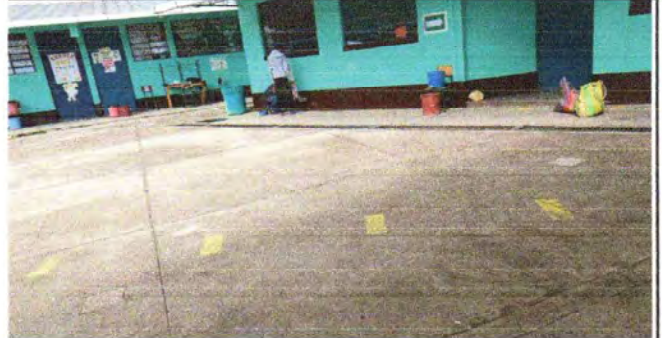
Foto 2: Aplicación de pintura en exterior de paredes
