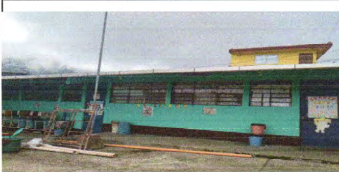
Foto 1: Colocación de Canal de agua pluvial al 100%
