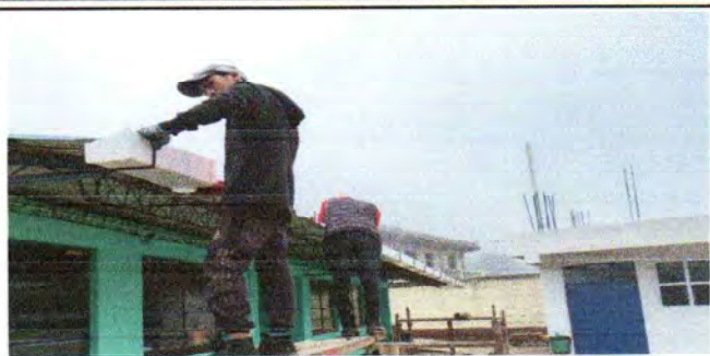
Foto 1: Sumistro e instalación de canal para agua pluvial.
