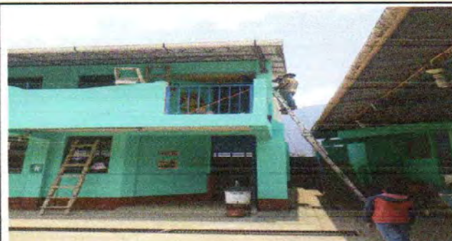
Foto 2: Suínistro y aplicación de pintura en la parte exterior de las paredes.
