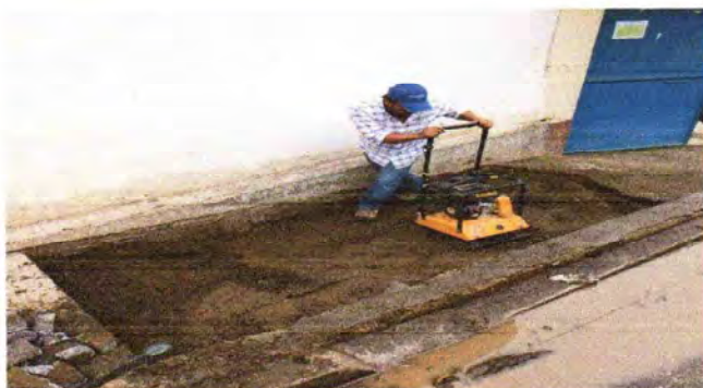
Foto 4: Reparación de banqueta
