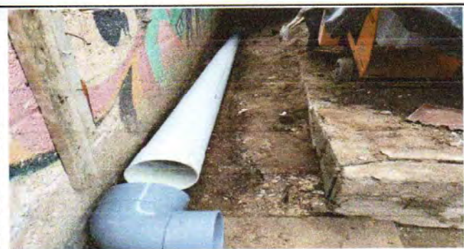
Foto 3: Suministro e instalación de drenaje.
