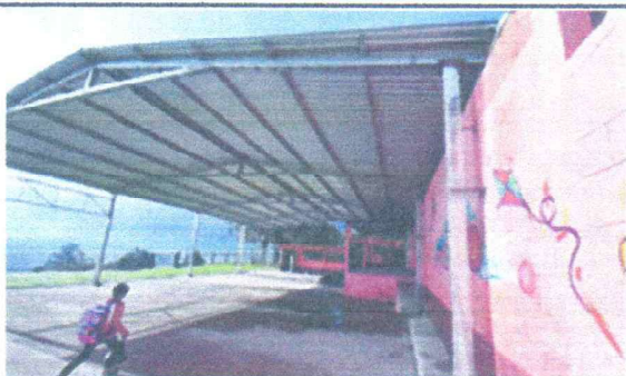
Foto1: VISTA INTERIOR LAMINA COLOCADA AL 100%
