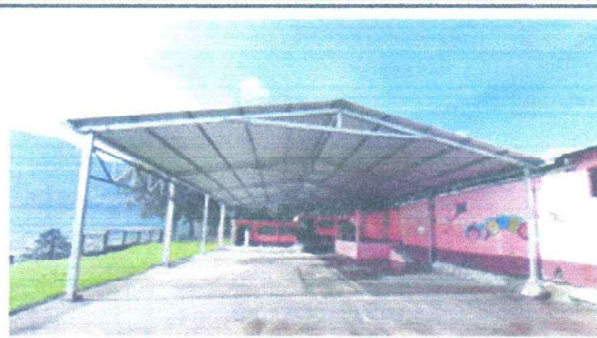
Foto 2: VISTA FACHADA DE LA ESTRUCTURA Y TECHO
