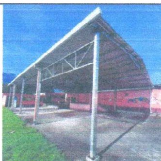
Foto 6: VISTA EXTERIOR ORIENTE, FINALIZADO
