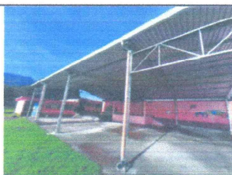
Foto 4: VISTA AMBOS LADOS DE LA ESTRUCTURA
