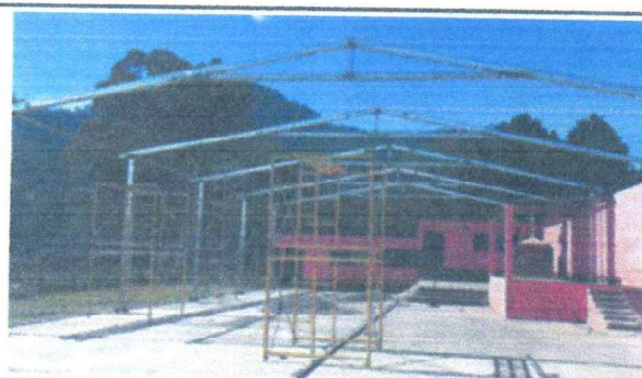
Foto 4: Instalación de estructura metálica
