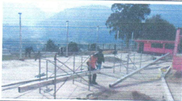
Foto 3: Suministro e instalación de estructura metálica
