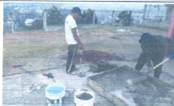
Foto 2: Suministro e instalación de bases para estructura metálica
