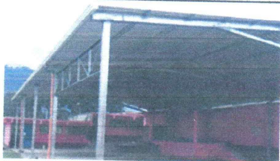
Foto 5: Suministro e instalación de láminas
