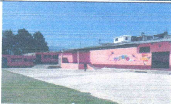
Foto 1: Patio anteriormente, sin techo.
