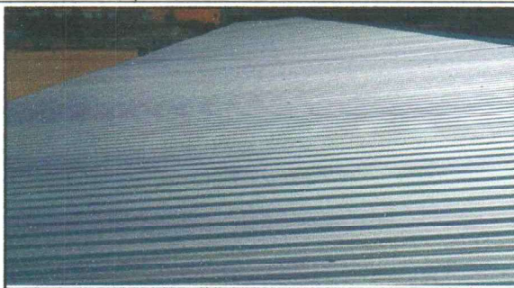
Foto 2: VISTA PANORÁMICA DE LÁMINAS NUEVAS INSTALADAS
