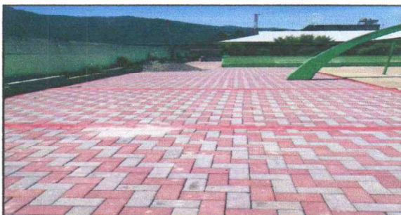
Foto 6: RUTA 2 DE DRENAJE INSTALADO Y CUBIERTO
