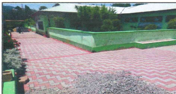
Foto 3: VISTA PANORÁMICA DE LA INSTALACIÓN DE ADOQUIN
