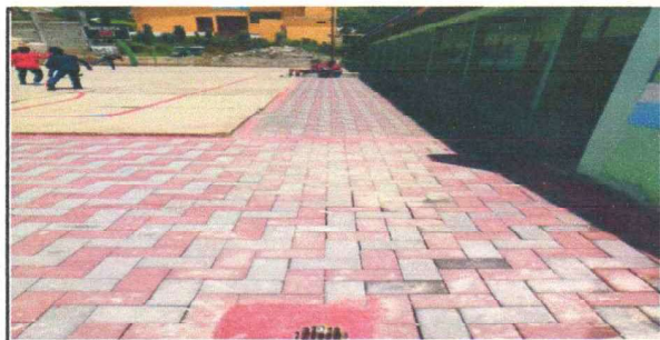
Foto 5: DRENAJE INSTALDO AL 100% Y CON ADOQUÍN
