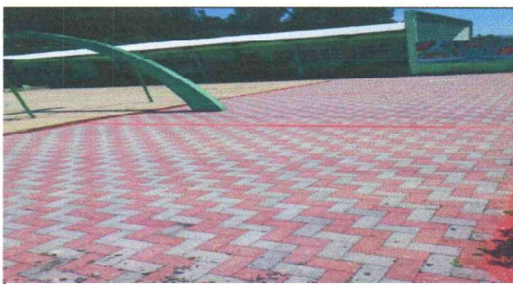
Foto 4: ADOQUÍN COLOCADO AL 100%
