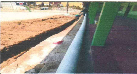
Foto 6: COLOCACIÓN DE TUBERÍA DE DRENAJE
