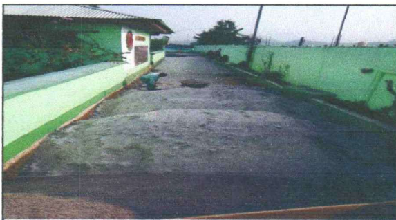
Foto 4: TRABAJO DE PREPARACIÓN DE TIERRA
