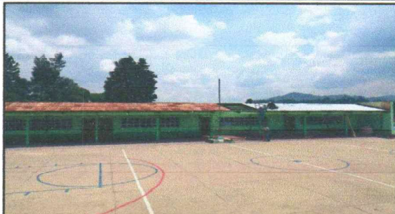
Foto 2: SUMINISTRO E INSTALACIÓN DE LÁMINA PRIMERA FASE
