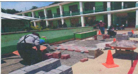
Foto 3: COLOCACIÓN DE ADOQUIN
