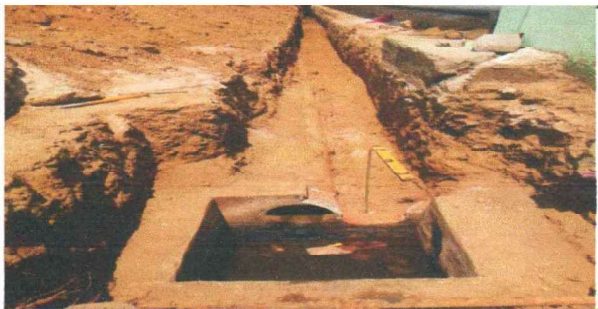
Foto 5: ZANGEO PARA COLOCACIÓN DE DRENAJE DE AGUAS NEGRAS
