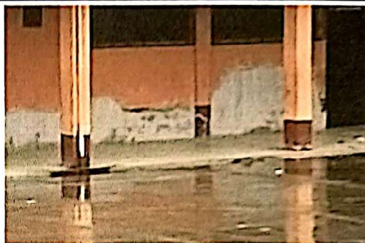
Resane de repello de muros
