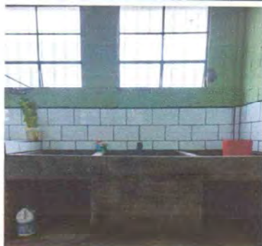
Foto1: Suministro e instalación pila para cocina finalizada AL 100%
