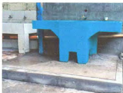
Foto 3: PILA INSTALADA CON TODOS SUS ACCESORIOS EL 100%
