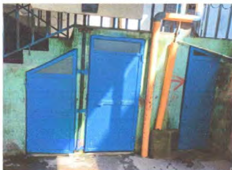
Foto1: Sustrucción de puertas metalicas para servicios sanitarios.
