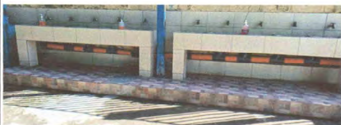
Foto 5: Suministro e instalacion de drenaje de lavamanos
