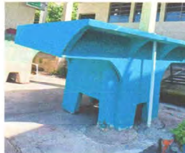
Foto 4: SEGUNDA PILA INSTALADA CON SU RESPECTIVO DRENAJE.
