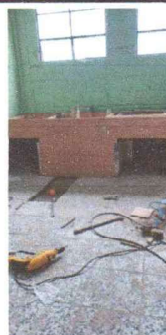
Foto 4: SUMINISTRO E INSTALACION PILA COCINA
