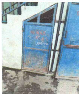
Foto 5: SUMINISTRO E INTALACION DE PUERTAS METALICAS
