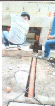
Foto 3: SUMINISTRO E INSTALACION DE DRENAJE
