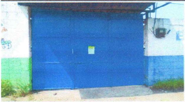
o 3: PORTONES Y VENTANAS COLOCADAS AL 100%
