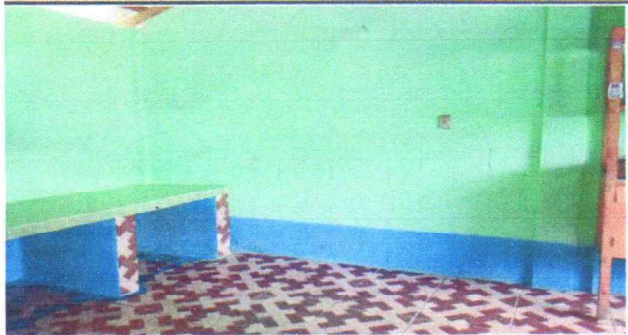
o 5: COLOCACIÓN DE PISO CERÁMICO FINALIZADO
