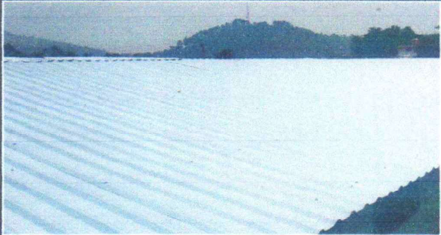
Foto 2: VISTA DE INSTALACIÓN DE LÁMINA FINALIZADO
