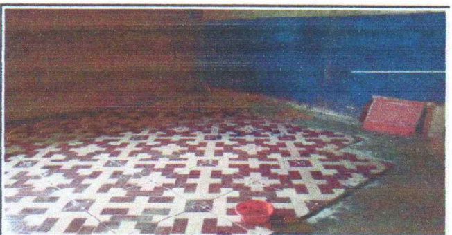
Foto 6: COLOCACIÓN DE PISO CERÁMICO
