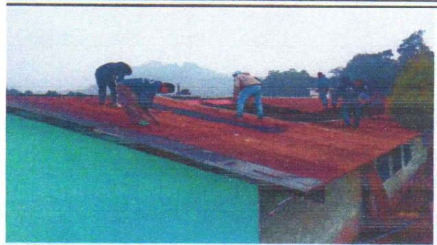
Foto 1: RETIRO DE LÁMINAS ANTIGUAS
