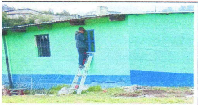
Foto 5: SUMINISTRO E INSTALACIÓN DE VENTANAS
