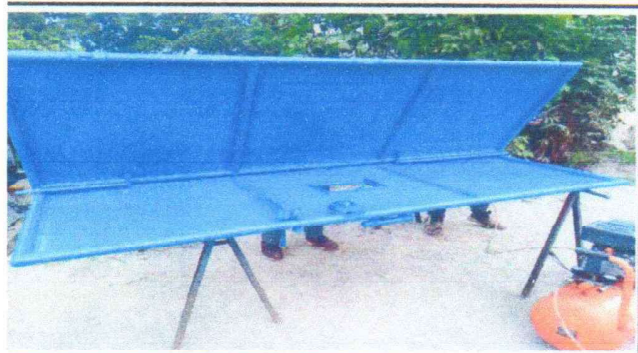
Foto 3: PINTURA Y REPARACIÓN DE PORTONES DE INGRESO
