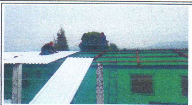
Foto 2: SUMINISTRO E INSTALACIÓN DE LÁMINA PRIMERA FASE
