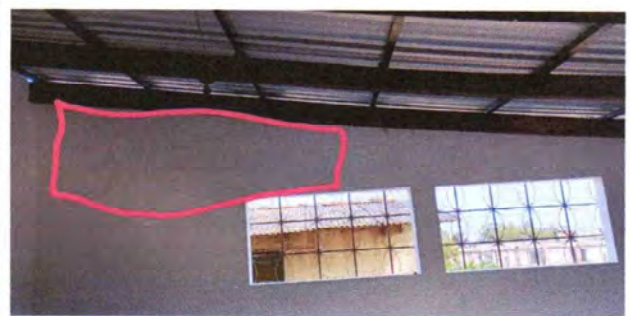
Foto 10: Suministro y mano de obra de relleno de espacios abiertos en paredes de 20 * 20
