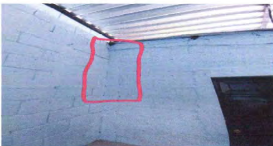
Foto 11: Suministro y mano de obra de terminación de columna 1.50*25
