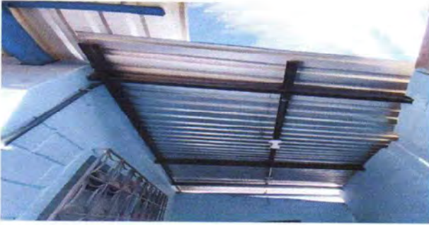
Foto13: Suministro e instalación de lámina troquelada Aluzinc calibre 26, incluye tornillos de 2 pulgadas con punta de roca de ferromax, suministro e instalación de 4 tubo de 2"32 y 2 tubos de 6"2 galvanizado chapa 16
