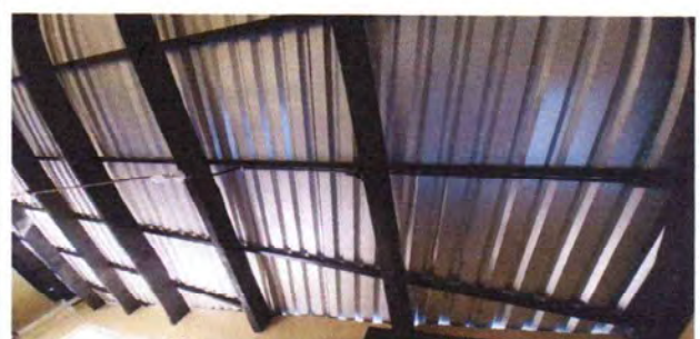
Foto 6: Desinstalación de techo e instalación de lamina troquelada Aluzinc calibre 26, incluye tornillos de 2 pulgadas con punta de roca de ferromax
