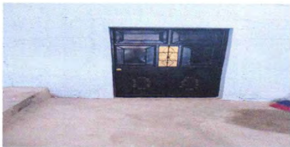
Foto 1: Mantenimiento de puerta (lijado, cambio de tubo, aplicación de dos manos de pintura anticorrosiva) de color negro, tubo de 1*1 chapa de 18
