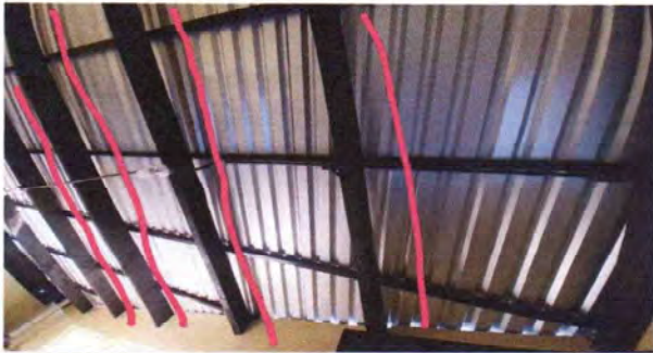
Foto 7: Mantenimiento de vigas existentes de madera (lijada y pintada)
