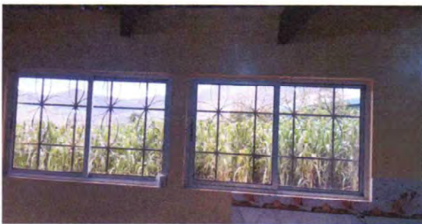
Foto 9: Suministro e instalación de ventanass de aluminio corredizo de vidrio de color bronce de 5 milímetros de grueso (con medida de 1.50 * 85 cm)
