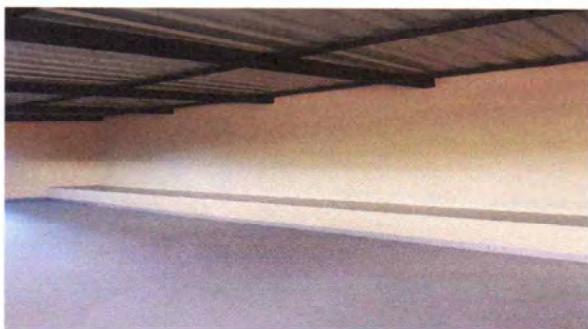
Foto 3: Suministro y mano de obra de repello, alisado y pintura de paredesinteriores (marca lanco de aceite)
