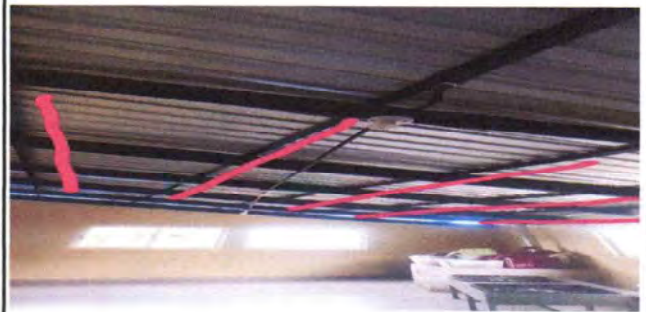
Foto 8: Suministro e instalación de tubo de 2"2 galvanizado chapa 16 y tornillo con punta fina
