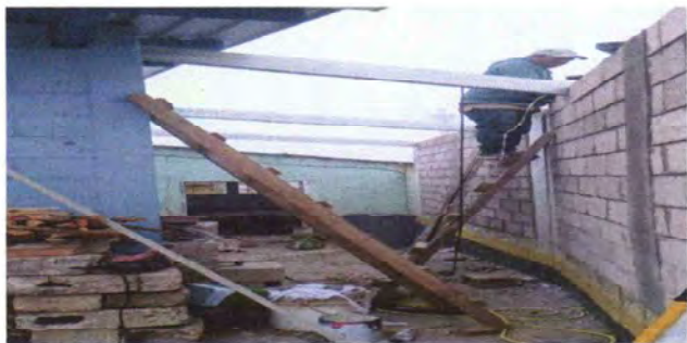
Foto 13: Suministro e instalación de lámina troquelada Aluzinc calibre 26, incluye tornillos de 2 pulgadas con punta de roca de ferromax, suministro e instalación de 4 tubo de 2"32 y 2 tubos de 6"2 galvanizado chapa 16
