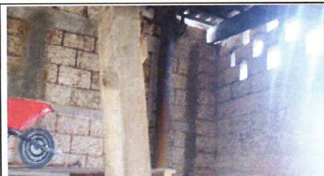
Foto 10: Suministro y mano de obra de relleno de espacios abiertos en paredes de 20 * 20
