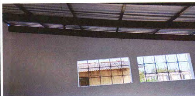
Foto 9: Suministro e instalación de ventanass de aluminio corredizo de vidrio de color bronce de 5 milímetros de grueso (con medida de 1.50 * 85 cm)
