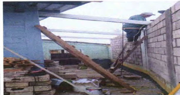
Foto 8: Suministro e instalación de tubo de 2"2 galvanizado chapa 16 y tornillo con punta fina
