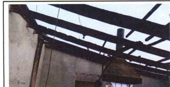
Foto 6: Desinstalación de techo e instalación de lamina troquelada Aluzinc calibre 26, incluye tornillos de 2 pulgadas con punta de roca de ferromax
