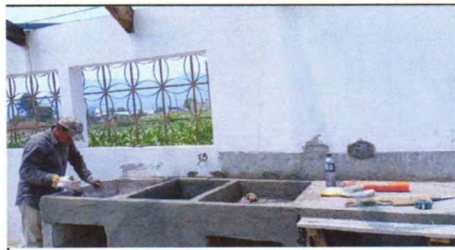
Foto 4: Suministro y mano de obra de pila con mesa de concreto, con dos aletas de lavaderos de 60 cm. Cada lado con su fosa de agua y su estantería, e instalación de tubo de agua en pila de concreto con su chorro
