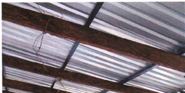
Foto 7: Mantenimiento de vigas existentes de madera (lijada y pintada)
