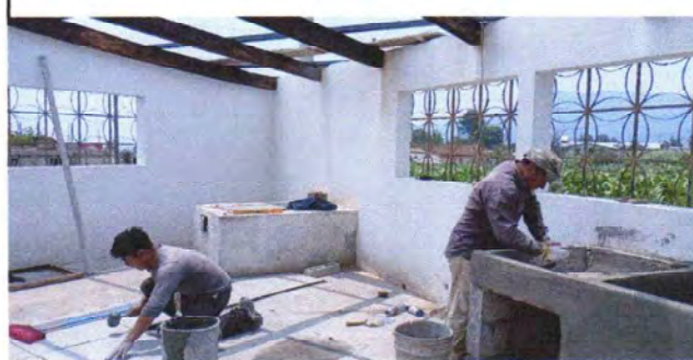
Foto 2: Suministro e instalación de piso cerámico antideslizante marca hispacensa con su adhesivo y sisa
