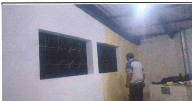
Foto 3: Suministro y mano de obra de repello, alisado y pintura de paredes interiores (marca lanco de aceite)
