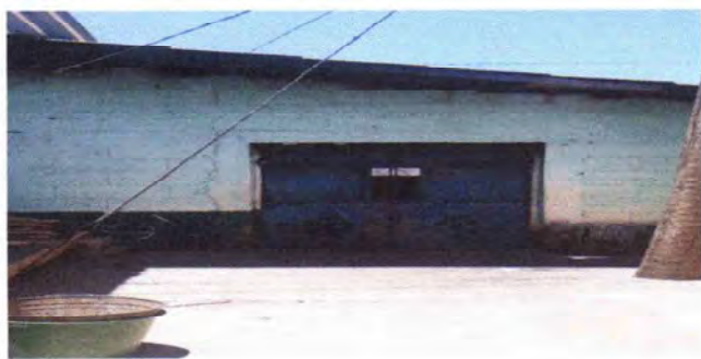
Foto 1: Mantenimiento de puerta (lijado, cambio de tubo, aplicación de dos manos de pintura anticorrosiva) de color negro, tubo de 1*1 chapa de 18
