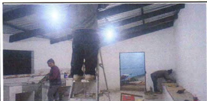
Foto 5: Suministro de azulejo e instalación para mesa de concreto marca hispacensa con su adhesivo y sisa
