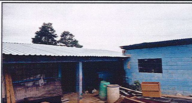
Foto1: Finalización de sustitución de lamina troquelada
