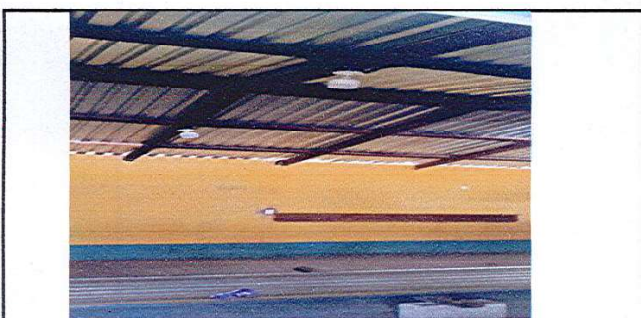
Foto 5: Terminación de instalación eléctrica
