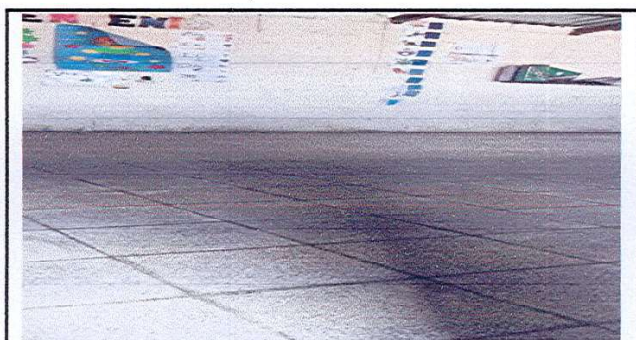
Foto 4: Finalización de colocación de piso granito
