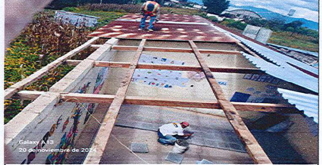
Foto 2: proceso de colocación de lamina troquelada calibre 24
