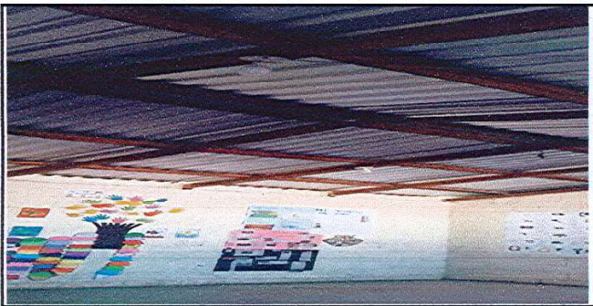
Foto 5: proceso de instalación eléctrica
