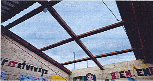
Foto 1: proceso de colocación de lamina troquelada calibre 24
