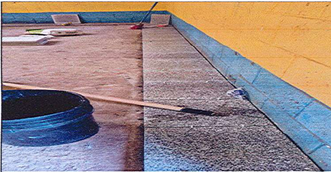
Foto 3: Colocación de piso granito
