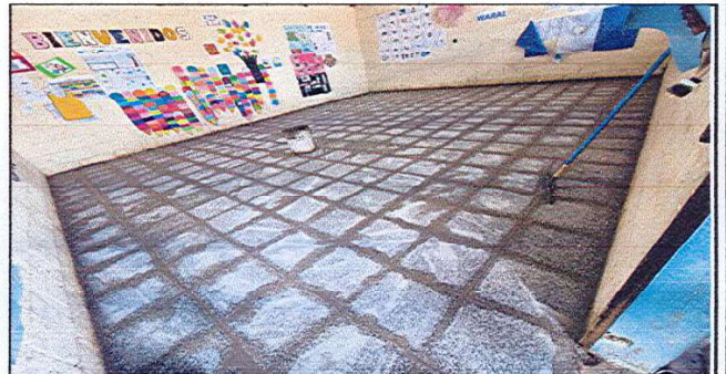
Foto 4: Colocación de piso granito
