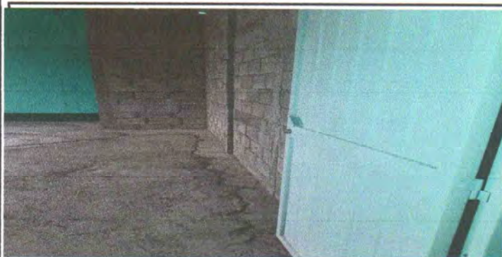
Foto 3: Remozamiento de puerta aula 1
