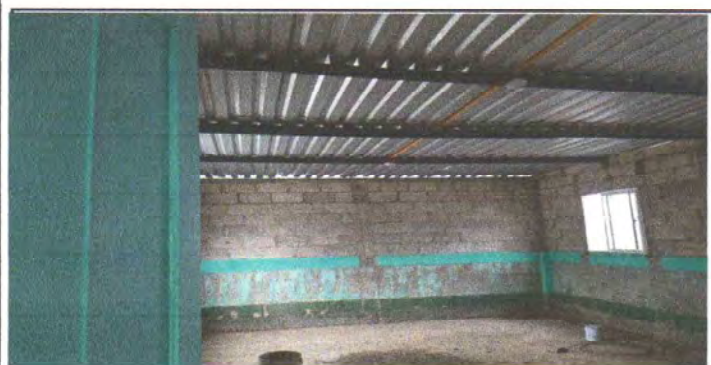
Foto 5: Remozamiento aula 2, techo, muro, iluminación
