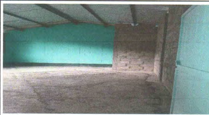
Foto 2: Remozamiento de estructura de techo
