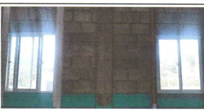
Foto 6: Remozamiento de ventanas
