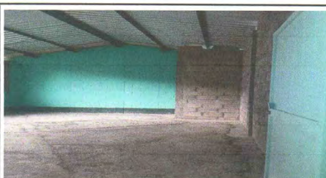
Foto 4: Remozamiento de techo
