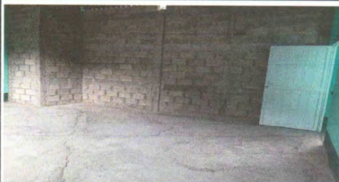
Foto 1: Remozamiento de muro
