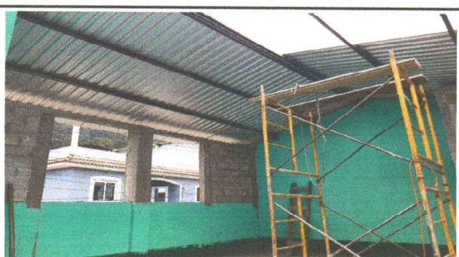
Foto 4: suministro e instalación de techo, aula
