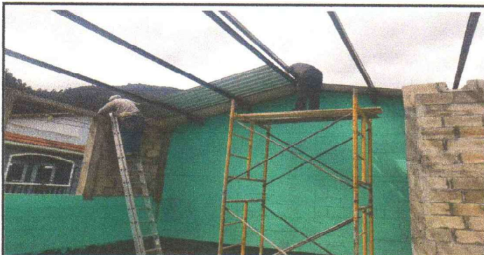
Foto 3: suministro e instalación de techo, aula 1
