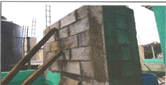
Foto 5: remozamiento de columnas, aula 2
