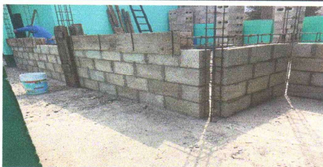
Foto 1: remozamiento de muro de aula 1
