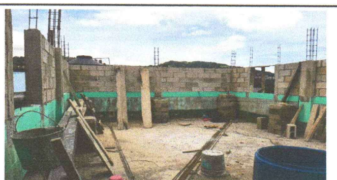
Foto 6: remozamiento de muro
