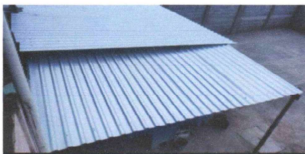
Foto 3: VISTA EXTERIOR TECHO DE PILA
