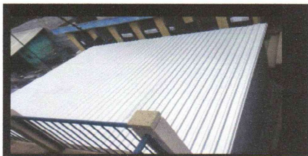
Foto1: VISTA EXTERIOR ENTECHADO DEL AULA
