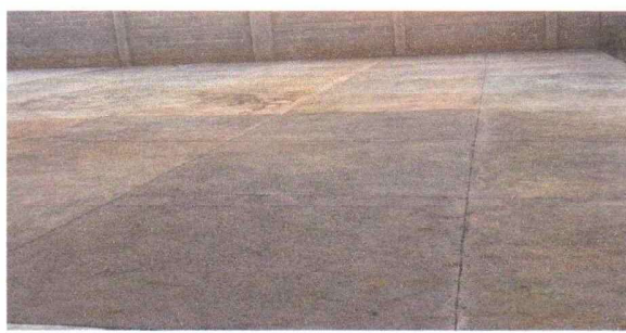
Foto 4: VISTA FUNDICIÓN LADO PONIENTE DEL PATIO
