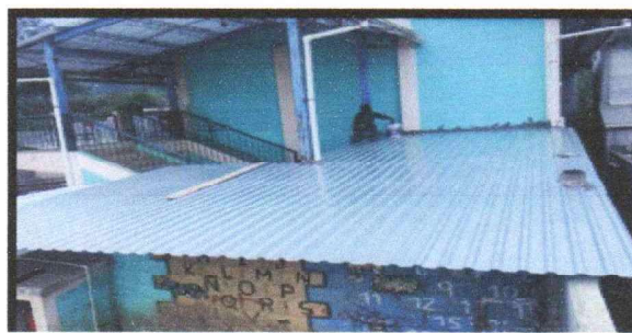
Foto 2: VISTA EXTERIOR ENTECHADO DE COCINA
