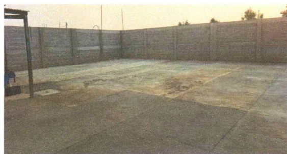
Foto 6: VISTA FUNDICIÓN COMPLETA DEL PATIO
