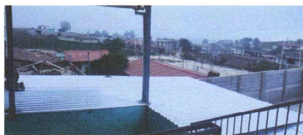
Foto 5: VISTA EXTERIOR LAMINA DE COCINA
