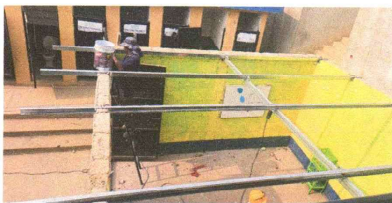
Foto 3: COLOCACIÓN DE ESTRUCTURA METALICA PARA LAMINA
