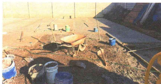
Foto 6: FUNDICIÓN DE PISO
