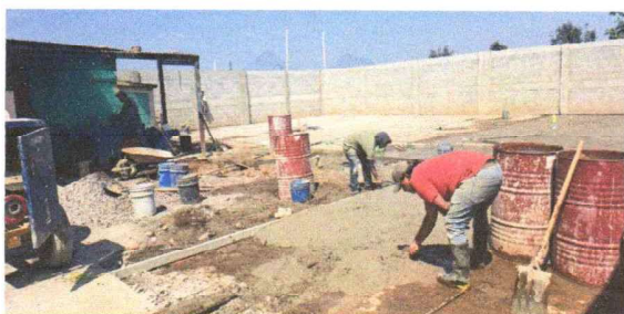
Foto 5: SEPARACIÓN DE BLOQUES Y FUNDICIÓN DE PISO
