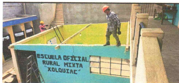
Foto 2: RETIRO DE MADERA DEL TECHO
