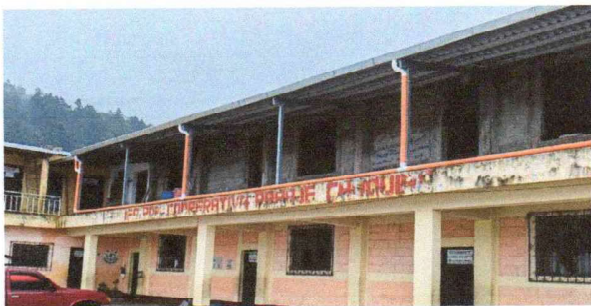
Foto 5: VISTA DE PERFIL DE AULAS CON SUMINISTRO E INSTALACIÓN DE LAMINAS Y BAJADAS DE AGUA PLUVIAL, FINALIZADA
