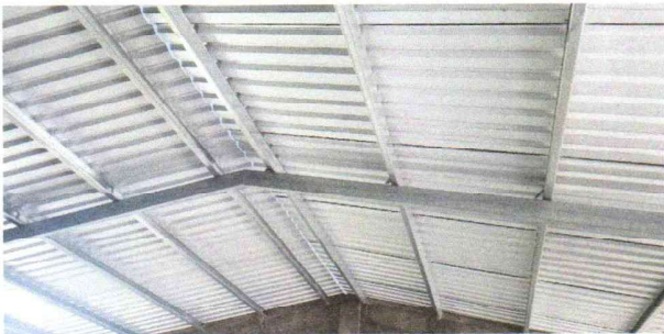
Foto 3: VISTA INTERNA DE AULAS CON ESTRUCTURA PORTANTE Y CUBIERTA DE LAMINA TROQUELADA AL 100%.
