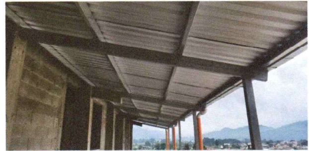
Foto 4: VISTA INTERIOS DE PASILLO AL 100%
