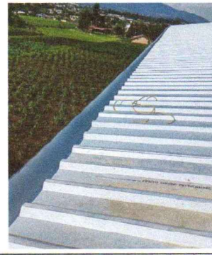
Foto 2: VISTA DE INSTALACIÓN DE CANALES Y BAJADA DE AGUA PLUVIAL, FINALIZADO
