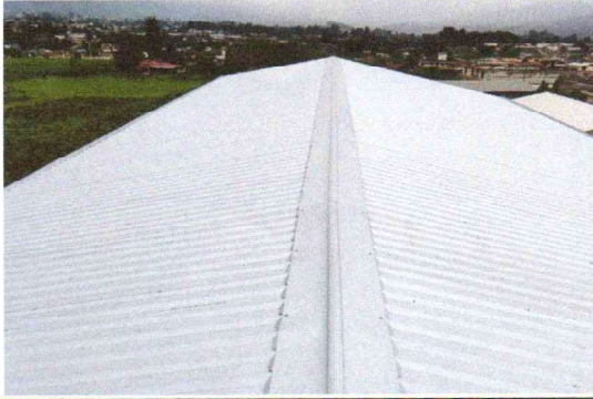
Foto1: VISTA AEREA DE CUBIERTA COLOCADA AL 100%
