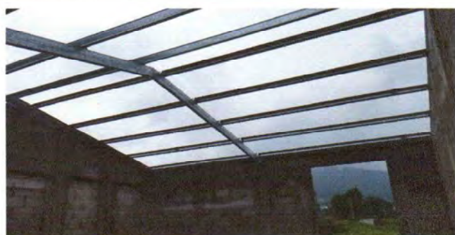
Foto 4: SUMINISTRO E INSTALACIÓN DE ESTRUCTURA PORTANTE VIATA INTERNA.
