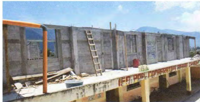
Foto 2: VISTA FRONTAL DEL EDIFICIO PARA SUMINISTRO E INSTALACION DE CANAL DE AGUA PLUVIAL
