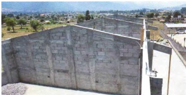
Foto 1: Vista aerea de areas a intervenir con suministro e instalacion de estructura portante y cubierta
