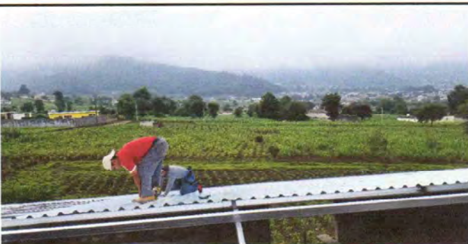
Foto 5: SUMINISTRO E INSTALACIÓN DE LÁMINAS
