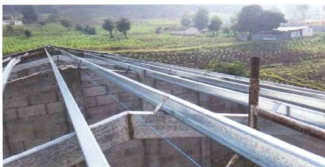
Foto 3: SUMINISTRO E INSTALACIÓN DE ESTRUCTURA PORTANTE VISTA AEREA
