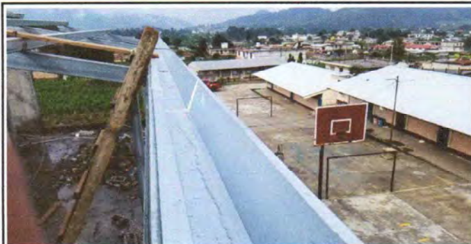
Foto 6: SUMINISTRO E INSTALACION DE CANAL DE AGUA PLUVIAL.
