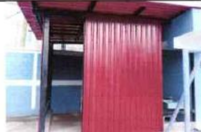
Foto 4: Instalación de lámina en bodega.
