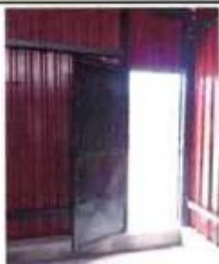
Foto 3: Reparación y reforzamiento de estructura en bodega.
