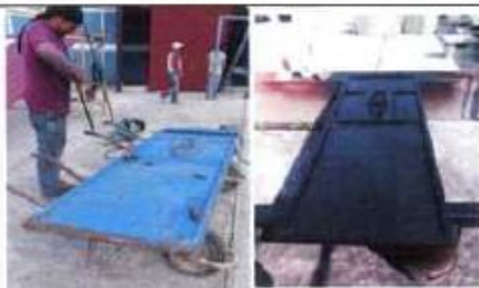
Foto 5: Remozamiento e instalación de puerta de metal en bodega.
