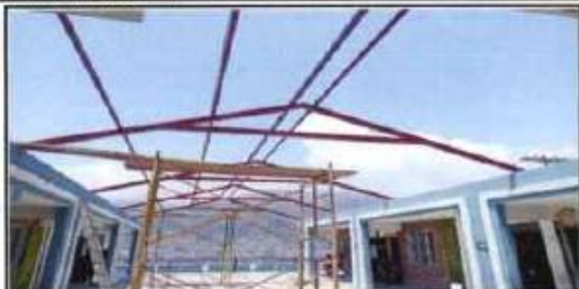
Foto 1: Estructura de techo de patio entre modulo 1 y 2
