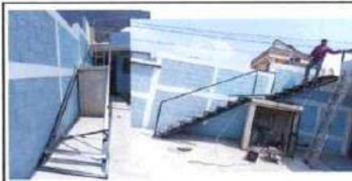
Foto 6: Fabricación e instalación de gradas de metal con baranda para subir al segundo nivel.
