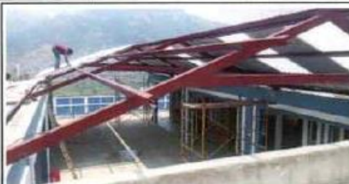
Foto 2: Entechado de patio entre modulo 1 y 2
