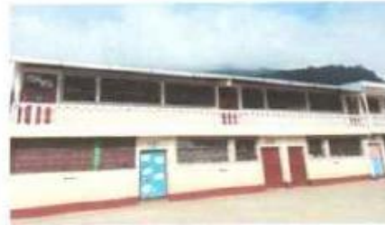
Foto 2: VISTA DE INSTALACIÓN DE LÁMINA FINALIZADO
