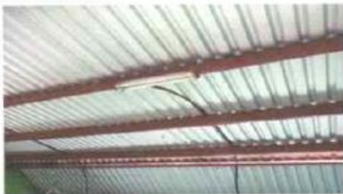
Foto 3: VISTA INTERIOR DE AULA A MANTENIMIENTO A ESTRUCTURA DE SOPORTE DE METAL CON ANTICORROSIVO
