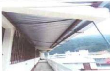
Foto 5: SUSTITUCIÓN DE CANALES DE AGUA PLUVIAL
