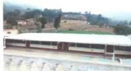
Foto 4: VISTA DE SUMINISTRO E INSTALACIÓN DE LÁMINA TROQUELADA CALIBRE 26
