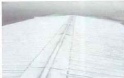
Foto 1: SUMINISTRO E INSTALACIÓN DE LÁMINA TROQUELADA CALIBRE 26
