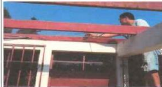
Foto 4: MANTENIMIENTO A ESTRUCTURA DE SOPORTE DE METAL CON ANTICORROSIVO
