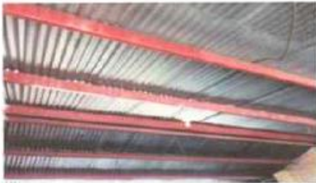
Foto 3: MANTENIMIENTO A ESTRUCTURA DE SOPORTE DE METAL CON ANTICORROSIVO
