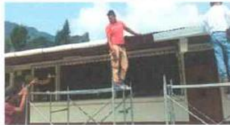
Foto 6: COLOCACIÓN DE CANALES DE AGUA PLUVIAL
