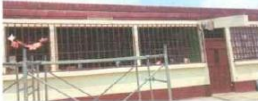
Foto 3: MANTENIMIENTO A ESTRUCTURA DE SOPORTE DE METAL CON ANTICORROSIVO
