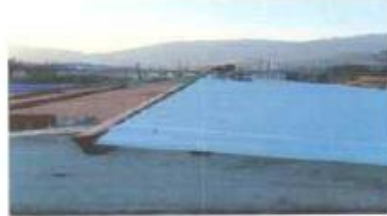
Foto 2: SUSTITUCIÓN Y MANTENIMIENTO DE LÁMINA TROQUELADA CALIBRE 26
