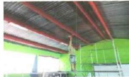
Foto 4: SEGUIMIENTO MANTENIMIENTO A ESTRUCTURA DE SOPORTE DE METAL CON ANTICORROSIVO
