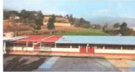
Foto 2: SUMINISTRO E INSTALACIÓN DE LÁMINA TROQUELADA CALIBRE 26
