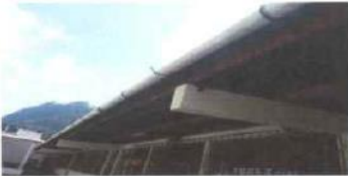
Foto 5 : SUSTITUCIÓN DE CANALES DE AGUA PLUVIAL
