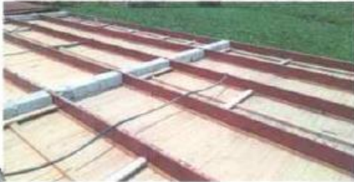
Foto1: RETIRO DE LÁMINAS
