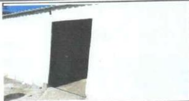
Foto 2: SUMINISTRO E INSTALACIÓN PLAYCE FINALIZADO
