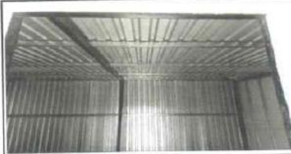
Foto 4: SUMINISTRO DE LAMINAS TRONQUELADA
