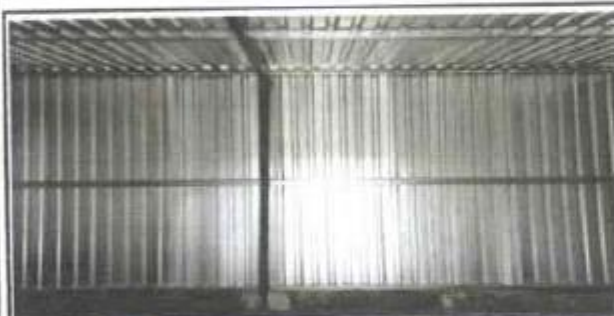
Foto 3: VISTA INTERIOR DE SUMINISTRO E INSTALACION DE LAMINA TRONQUELADA
