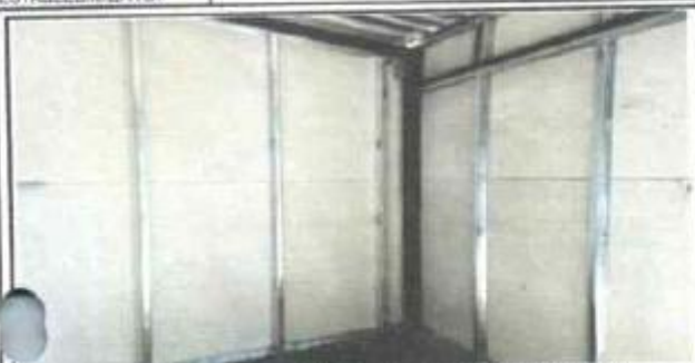
Foto 1: SUMINISTRO E INSTALACIÓN EN INTERIOR DE PLAYCE EN COCINA
