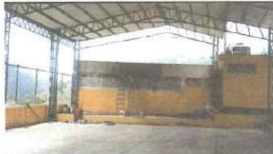
Foto 4: SUMINISTRO Y FABRICACION DE PARED DE BLOK
