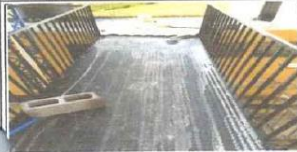
Foto 1: Suministro, fabricación e instalación de rampa con baranda de metal.
