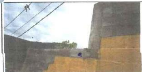
Foto 5: SUMINISTRO Y FABRICACION DE PARED BLOK
