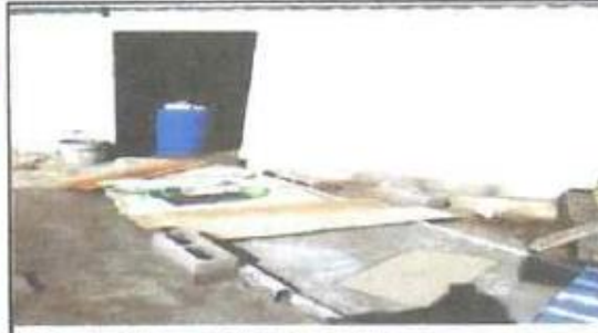
Foto 2: Suministro y recubrimiento con playce
