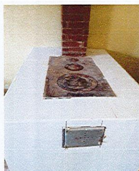
SUSTITUCION DE ESTUFA CON LADRIO Y CHIMENEA
