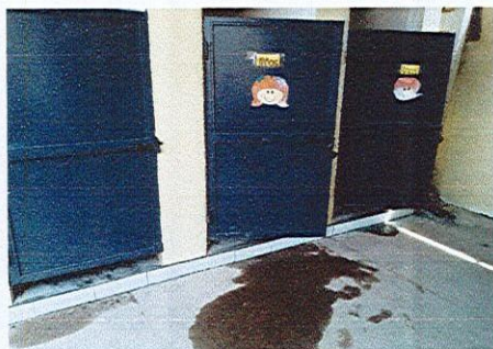
MANTENIMIENTO DE PUERTA DE METAL
