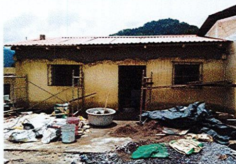
Sustitución de repello y colocación de lámina troquelada.
