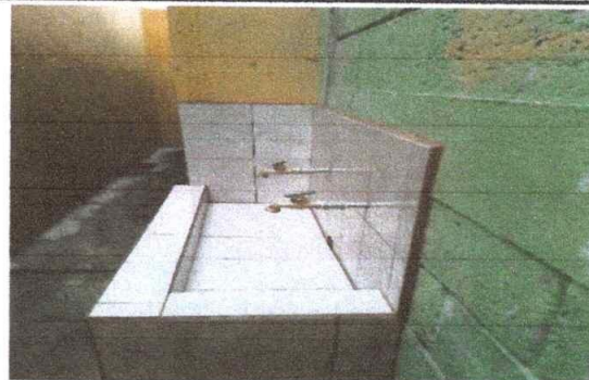
Sustitución de llave de chorro en lavamanos.
