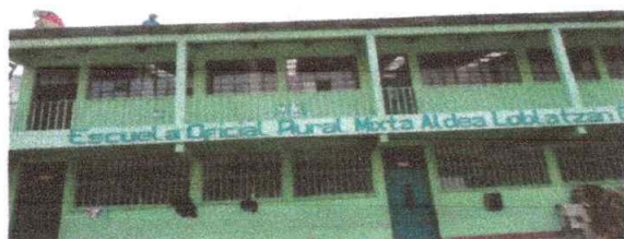
Sustitución de lámina, por lamina acanalada cal. 26.
