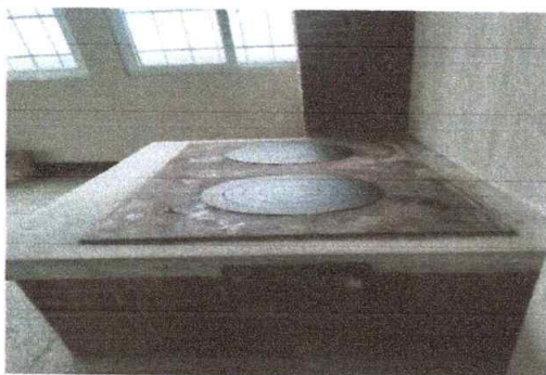
Reparación de estufa de leña con chimenea.
