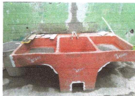
Sustitución de pila prefabricada de concreto de dos alas.
