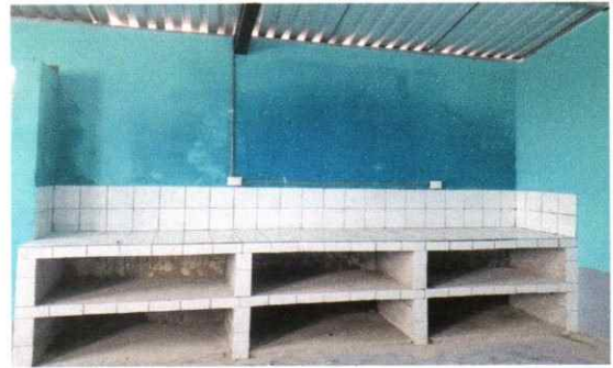
SUMINISTRO E INSTALACION DE GABINETES INSTALADOS
