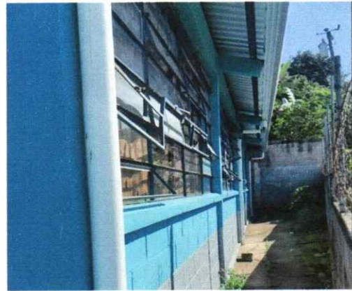
SUMINISTRO E INSTALACION DE LAMINAS EN AULAS
