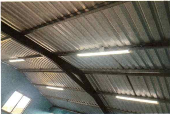
SUMINISTRO E INSTALACION DE ILUMINACION
