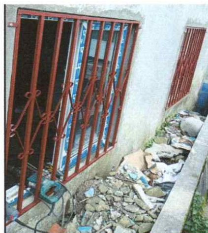
INSTALACION DE VENTANAS PVC Y BALCONES
