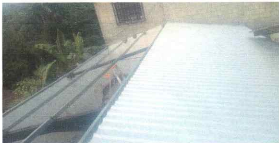
CUBIERTA DE LAMINA EN EJECUCION
