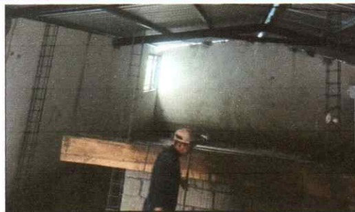
TRABAJOS DE CUBIERTA DE LAMINA
