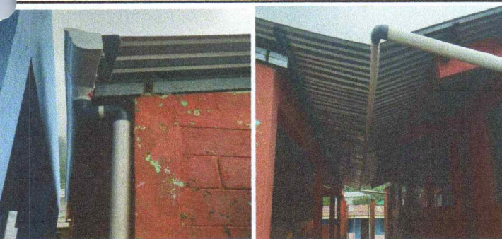
Foto 5: VISTA DE INSTALACIÓN DE CANAL FINALIZADO
