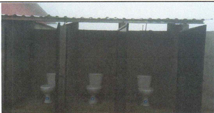
Foto 3: VISTA DE SUMINISTRO E INSTALACIÓN DE SANITARIOS ALDOSA Y PUERTAS DE METAL CON PASADOR FINALIZADO
