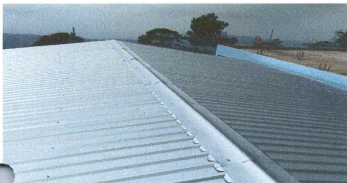
Foto 1: VISTA FACHADA DE LAMINAY CAPOTES COLOCADA AL 100%
