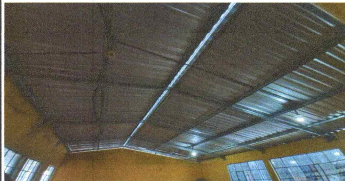
Foto 2: VISTA DE SUMINISTRO E INSTALACIÓN DE LÁMINA Y SOPORTE METAL FINALIZADO
