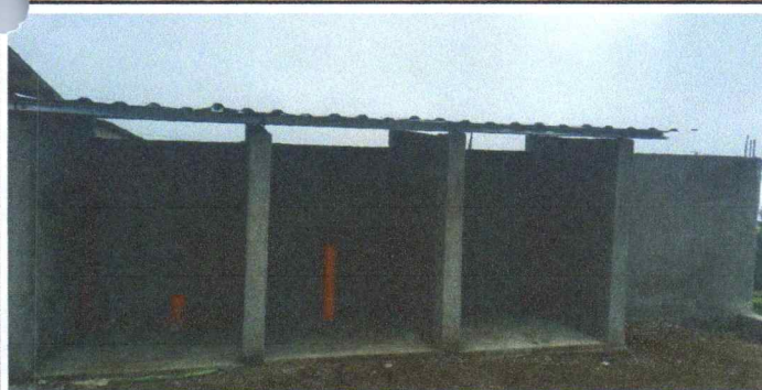
Foto 5: SUMINISTRO SUSTITUCIÓN DE MURO
