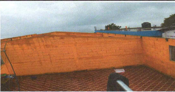
Foto 3: RETIRO DE LAS ESTRUCTURAS ANTIGUAS
