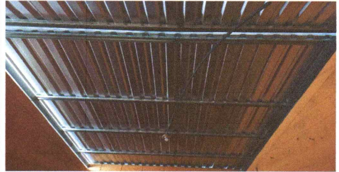
Foto 2: SUMINISTRO E INSTALACIÓN DE LÁMINA PRIMERA FASE
