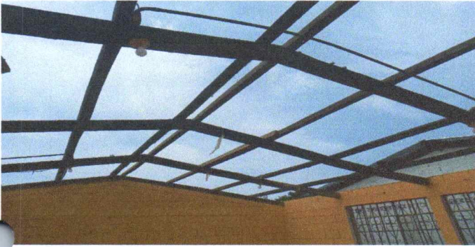
Foto1: RETIRO DE LÁMINAS ANTIGUAS
