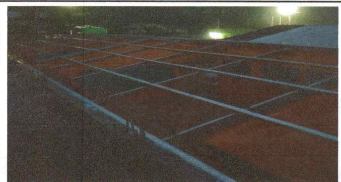
Foto 4: SUMINISTRO E INSTALACIÓN DE ESTRUCTURA DE SOPORTE METAL
