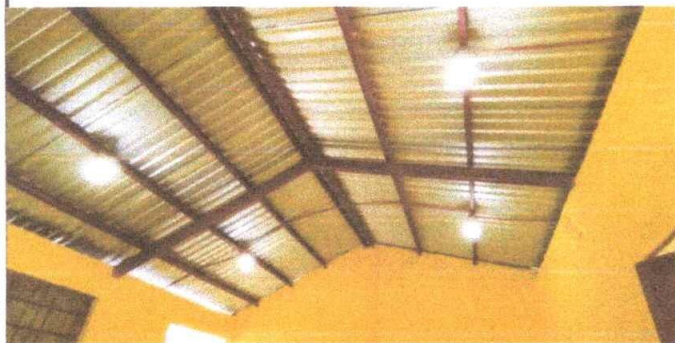
SUMINISTRO Y COLOCACION DE FOCOS LED
