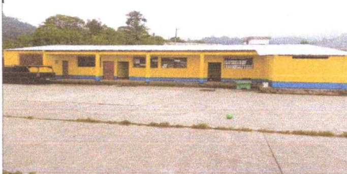
SUMINISTRTO Y COLOCACION DE LAMINA TROQUELADA CALIBRE 26
