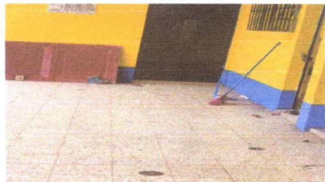
SUMINISTRO Y COLOCACION DE PUERTA DE METAL
