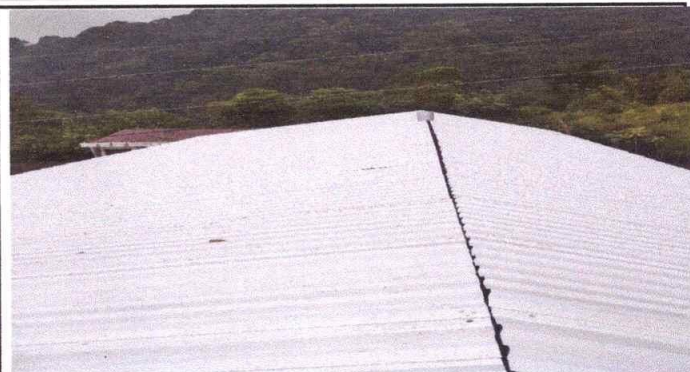
FOTO 2: SUMINISTRTO Y COLOCACION DE LAMINA TROQUELADA CALIBRE 26
