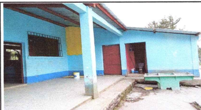
FOTO4: SUMINISTRO Y COLOCACION DE PUERTA DE METAL
