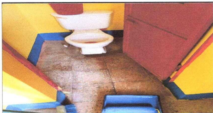
Foto 5: Suministro y colcación de baños aldosa blanco incluye accesorios
