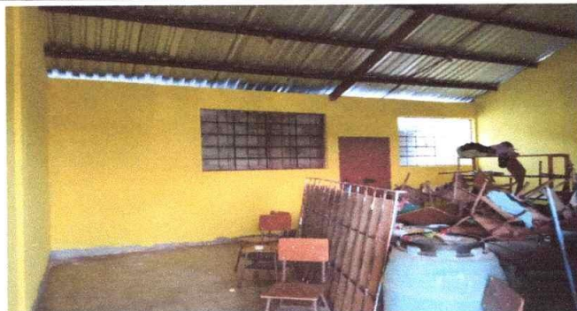
FOTO1: SUMINISTRO Y COLOCACION DE FOCOS LED
