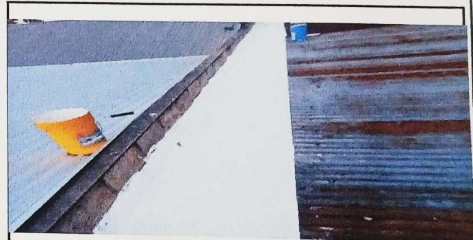
Suministro y aplicación de Impermeabilizante acrilico
