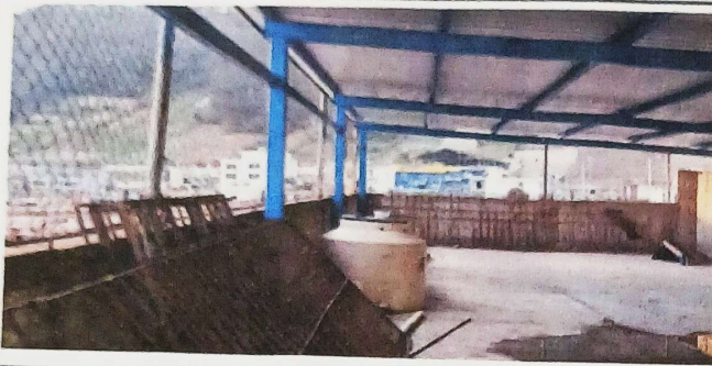
Sustitución de estructura de madera de techo área recreativa por metalico
