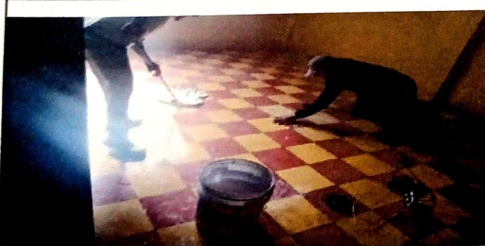
Pulido de piso de baldosa de concreto
