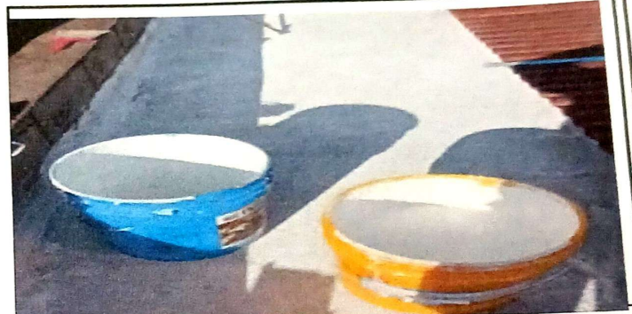
suministro y aplicación de impermeabilizante acrílico
