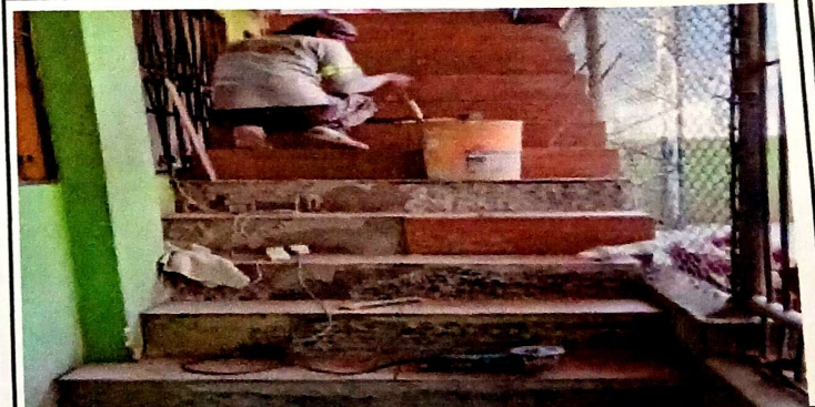
Sustitución de piso cerámico en módulo de gradas Sustitución de pasamanos metálico en módulo de gradas
