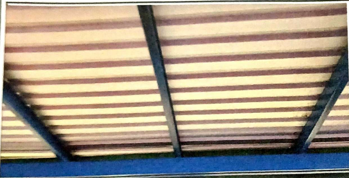
Sustitución de estructura de madera de techo de área recreativa por metálico
