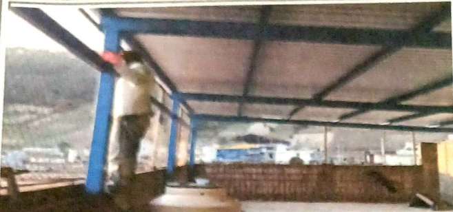
Sustitución de estructura de madera de techo de área recreativa por metálico
