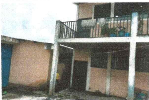
Foto 5: CULMINACION DE BARANDA 100%
