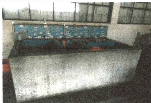
Foto 2: CULMINACION DE PILA 100%
