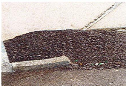
Foto 5: PIEDRIN PARA MANTENIMIENTO DE COCINA
