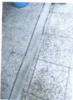
Sustitución de bordillo para puerta de ingreso a aula
