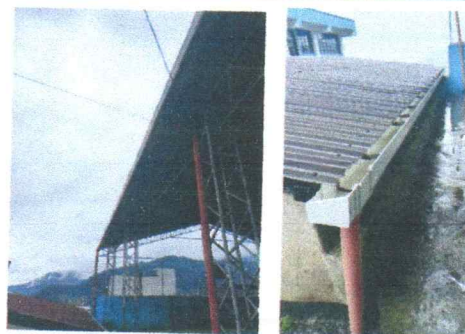
Sustitución de canal de desagüe en cancha
