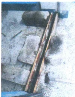
Sustitución de bordillo para puerta de ingreso a aula
