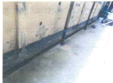
Sustitución de canal de desagüe en cancha
