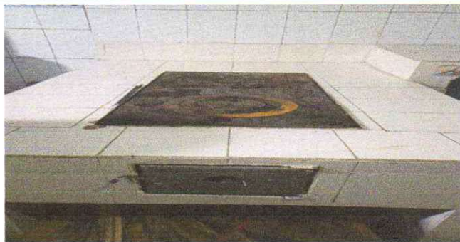
Mantenimiento de Cocina
