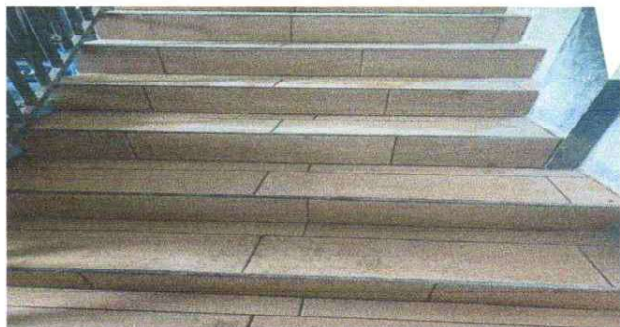
Suministro e instalacion de piso de gradas
