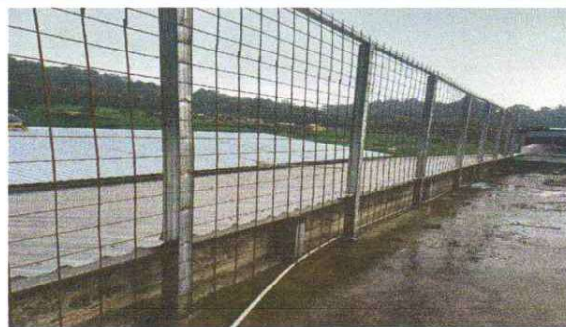
Suministro e instalacion de malla perimetral incluye columnas de seguimiento en circulación
