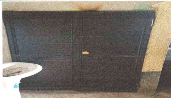
Sustitución de puerta de metal con chapa
