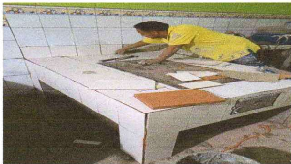
Mantenimiento de Cocina
