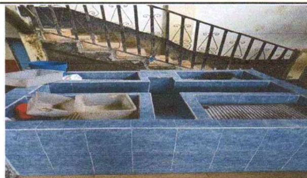
Sustitucion de tanque de almacenamiento de agua y lavadero
