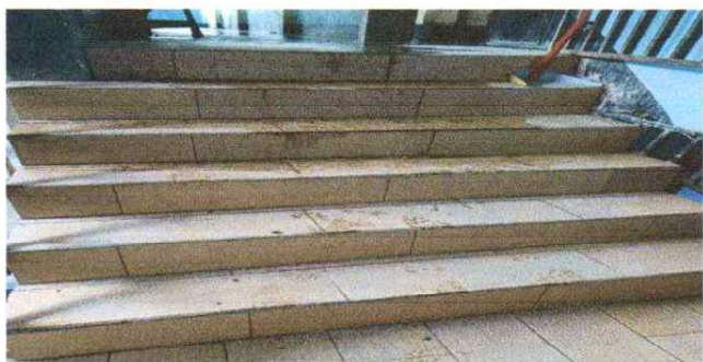
Suministro e instalacion de piso de gradas
