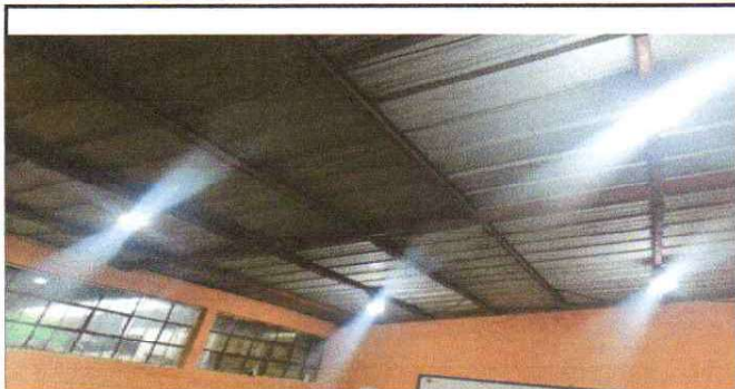
INSTALACION DE UNIDADES DE SISTEMA ELECTRICO
