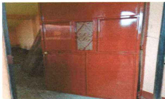
CAMBIO DE PUERTAS
