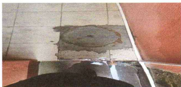
ELABORACION DE CAJAS DE REGISTRO DE AGUAS NEGRAS
