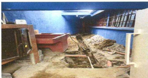
REMOZAMIENTO DE DRENAJE TAPADO DE LA COCINA
