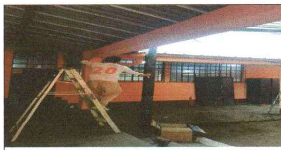
Instalación de Canal Pluvial
