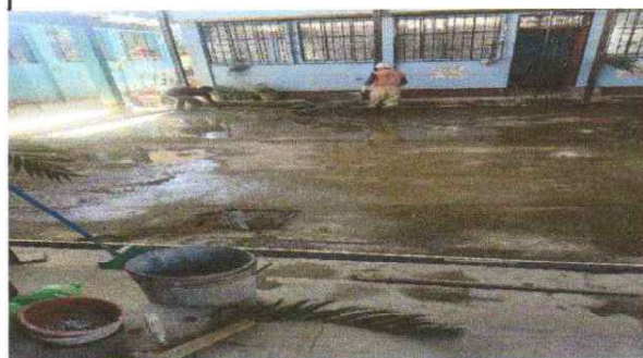
REMOZAMIENTO DE DRENAJE MODULO PRINCIPAL
