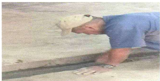
SUMINISTRO E INSTALACION DE TUBO DE DRENAJE
