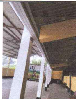
COLOCACION DE CANALES EN EL PATIO UNO
