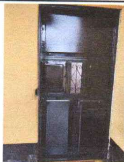
INSTALACION DE UNA PUERTA DE UN AULA
