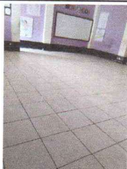
MEJORAMIENTO DE PISO RUSTICO POR PISO CERAMICO DE TRES AULAS
