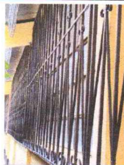
PINTURA DE BALCONES PATIO UNO
